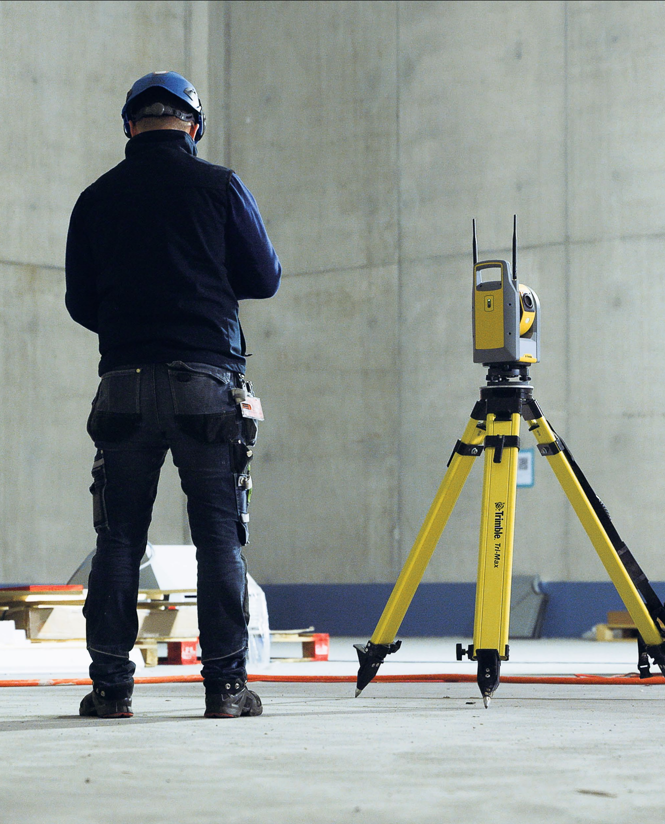
Während die Robotertotalstation für exakte Vermessung sorgt, ermöglicht das Tablet den sofortigen Zugriff auf alle Projektdaten, insbesondere das Informationsmodell. Foto: ZVG
