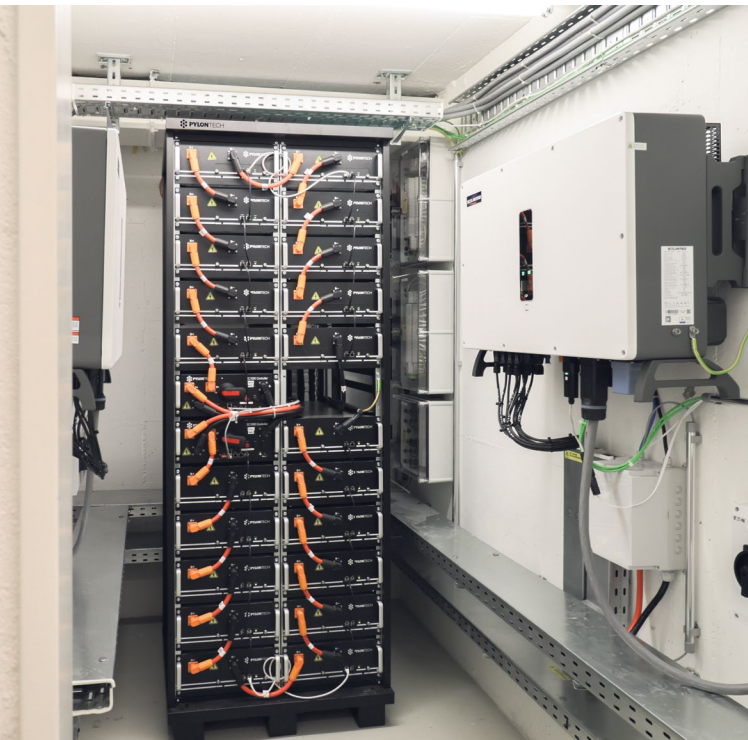
Solar-Gewerbespeicher. Foto ELEKTRON AG
